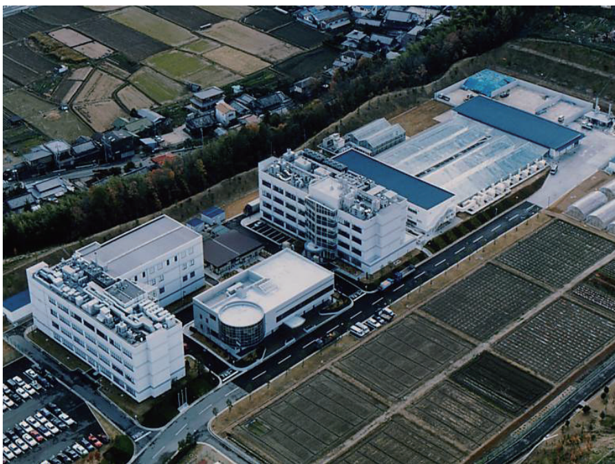
図-1 総合研究所の全景(大阪府河内長野市)
