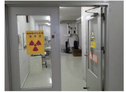
図-5 RI施設内のNMR室
