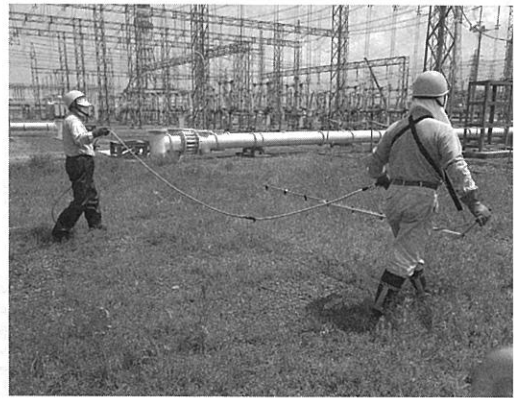
写真-7 変電所構内での薬剤散布
