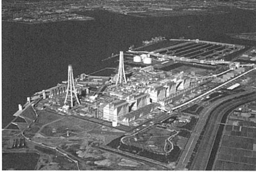
写真-1 火力発電所
