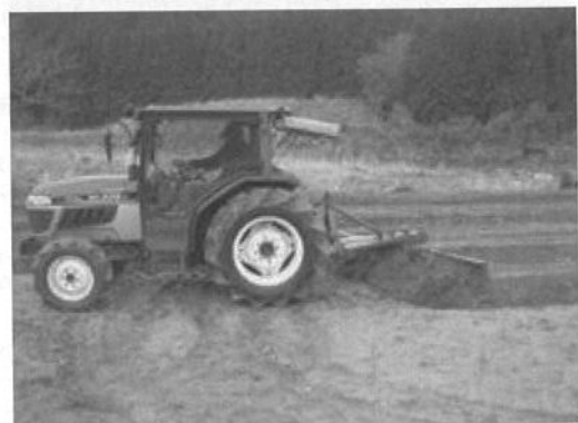
図-6 リアグレーダで表層を剥離
