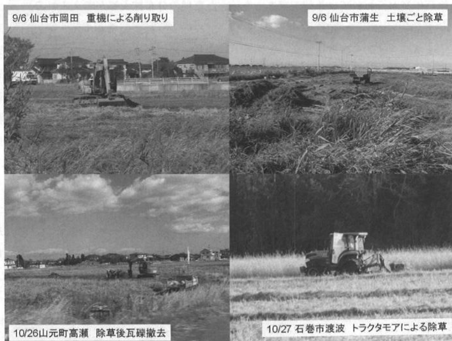
図-12 多様な農地復旧作業の行程
