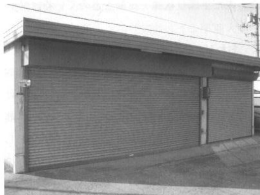
写真-4 作業場と道具・資材置き場
